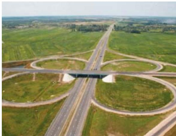
11 существующих транспортных развязок останутся без изменений. Предусмотрено строительство еще четырех развязок на 44, 62, 72 и 75 км дороги. Будет построена транспортная развязка на подъезде к Хатыни (54,48 км). Проект реконструкции предусматривает ремонт 11 путепроводов, восьми мостов через реки. Будет построено три перехода для диких животных и семь пешеходных переходов на разных уровнях.
