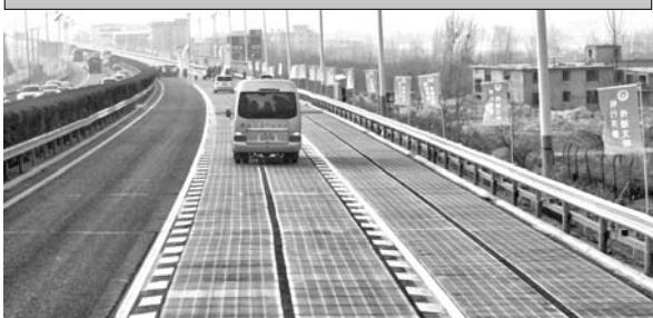
Дорожное покрытие выполнено из прозрачного и прочного материала, который позволяет одновременно выдерживать весовую нагрузку и пропускать солнечный свет.
